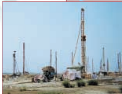
建設中の 広州JFE鋼板工場
